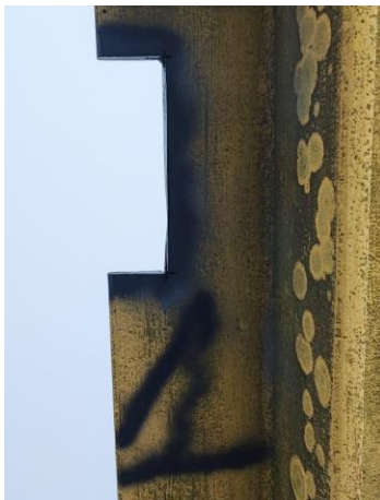
Figura 1 – Trecho de remoção da amostra para ensaio mecânico
