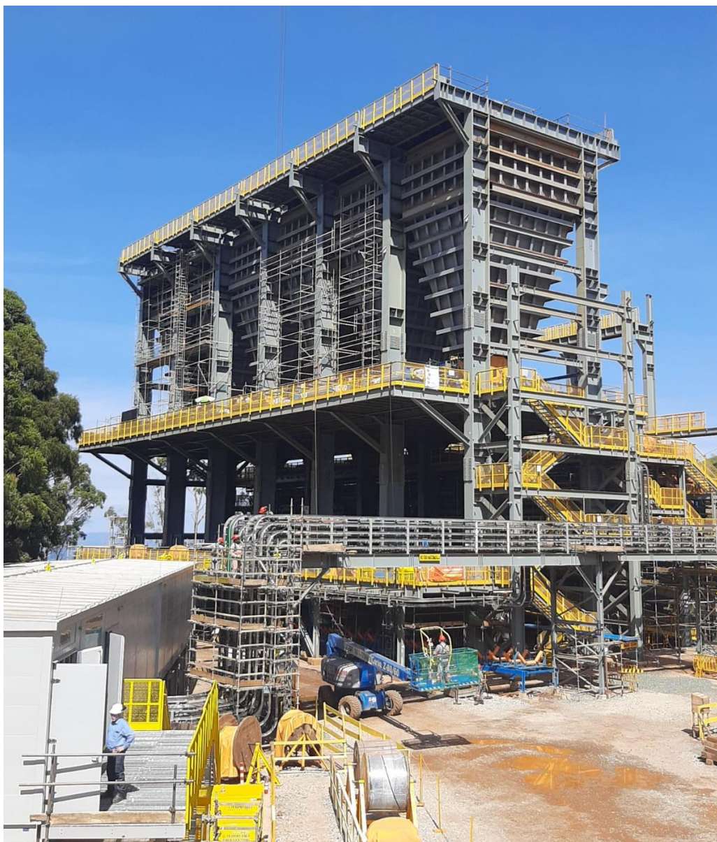
Figura 21- Montagem do Prédio do Peneiramento Terciário
