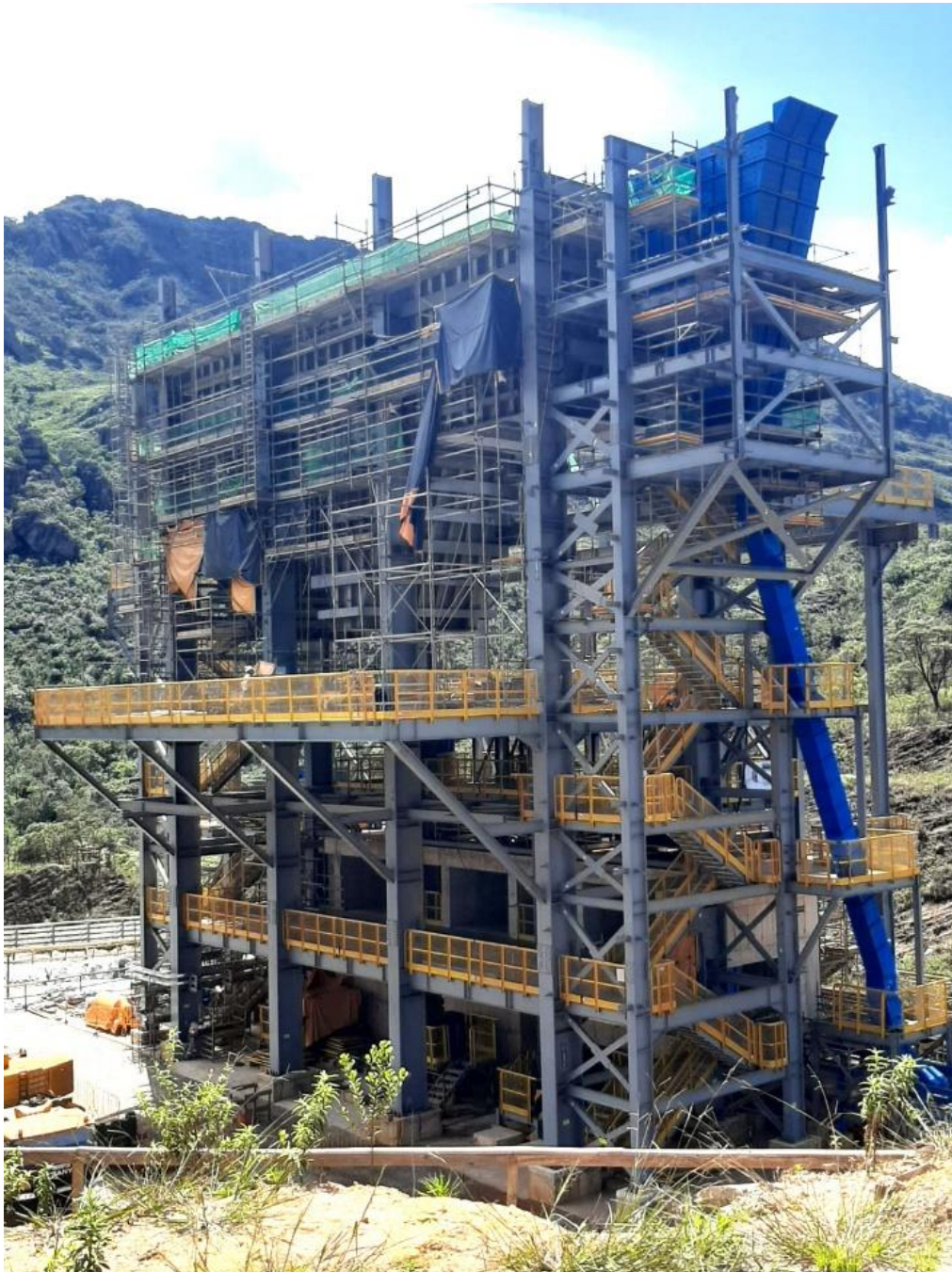
Figura 22- Montagem do Prédio da Britagem Terciária
