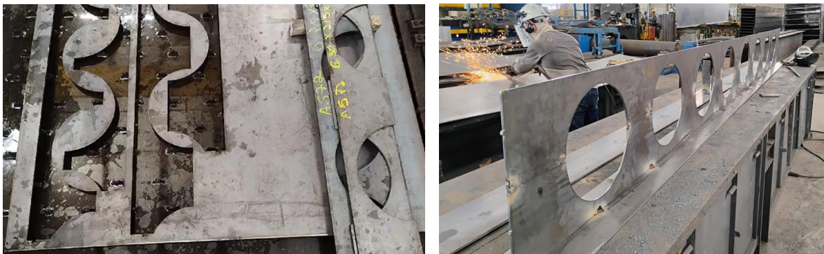
Figura 7 – Corte e montagem de uma viga celular soldada. (fotos: Hermano Cardoso)
