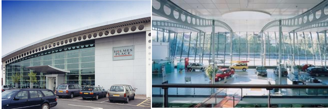
Figura 14 – Holmes Place Fitness Club, Merton (fonte: www.westok.co.uk – acessado em 11/05/2011); e concessionária com viga alveolar com dupla curvatura (fonte: http://www.cmcsteelproducts.com – acessado em 11/05/2011).
