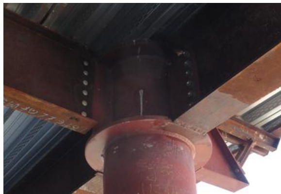
Figura 3: Exemplo de ligação de pórtico entre um pilar CHS e vigas em perfil “I”
