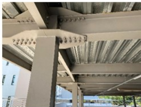
Figura 14: Viga Mista Fonte: Autor
