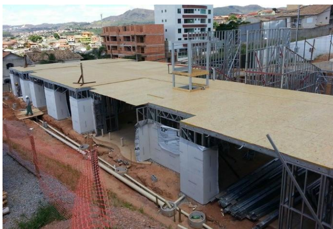
Figura 5- Laje de LSF com substrato seco em placas OSB
