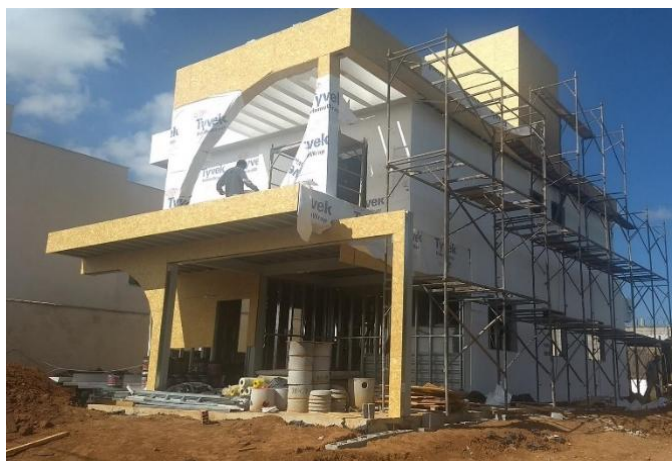
Figura 2 - Execução de fechamentos externos de LSF em edificação
