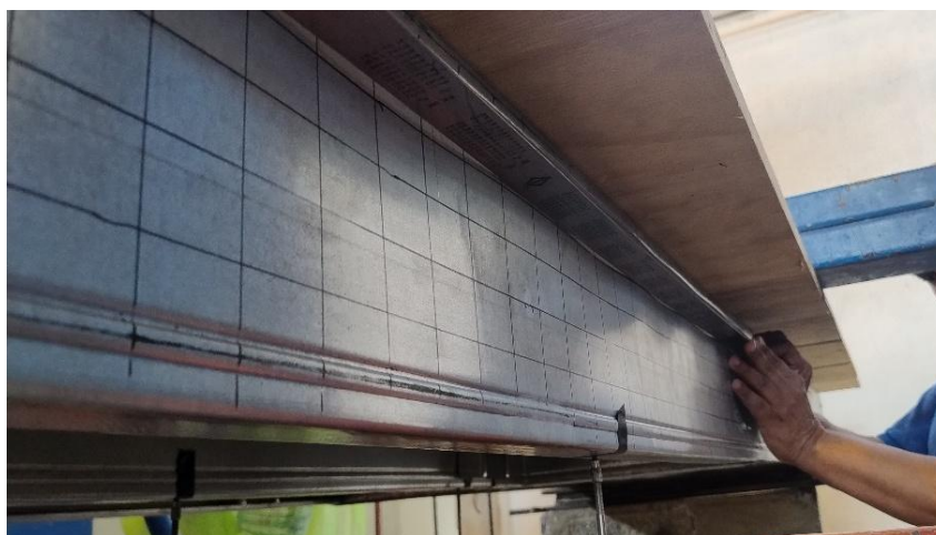
Figura 23 – Flambagem distorcional no perfil do CP-B da laje L-2
