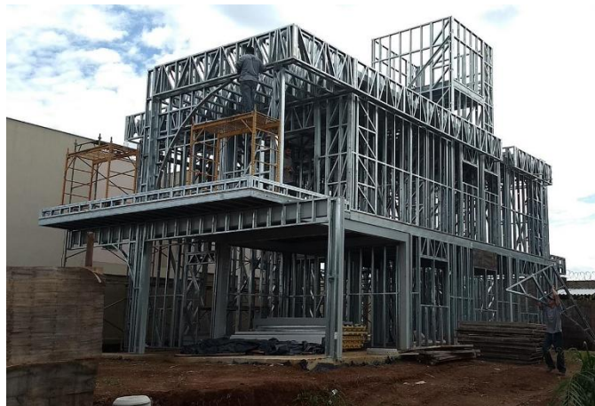
Figura 1 - Esqueleto estrutural de edificação em LSF
